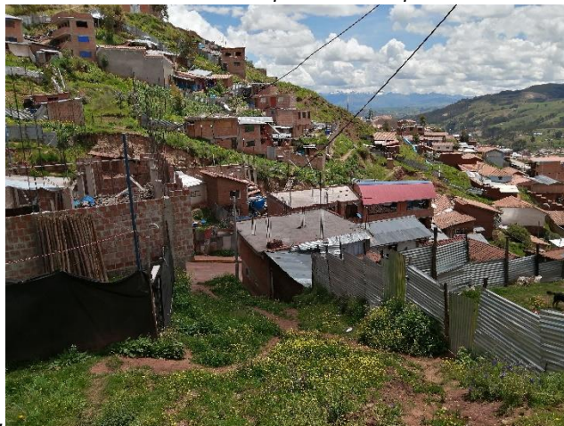
Imagen N° 21: Viviendas en laderas empinadas susceptibles a deslizarse en la
