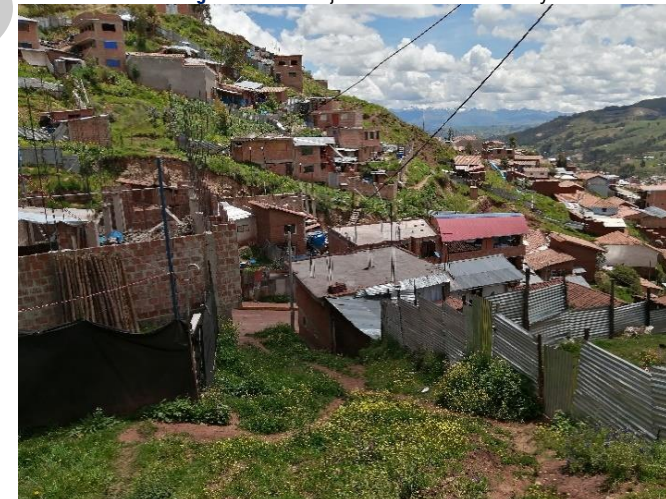
Imagen N° 45: Pasaje 05 de conservación muy mala
